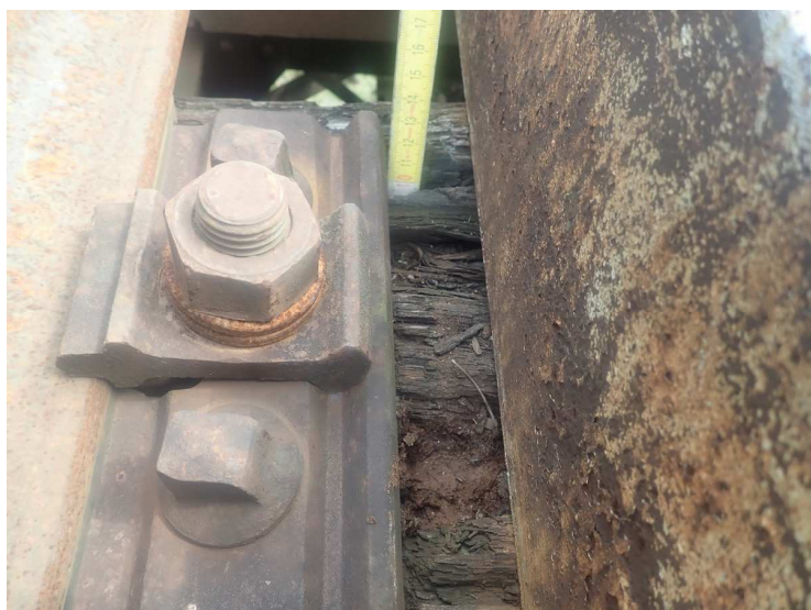
Foto č. 5 Železniční svršek – konstrukce K 01 – mostnice č. 31 vpravo – prohnílá
