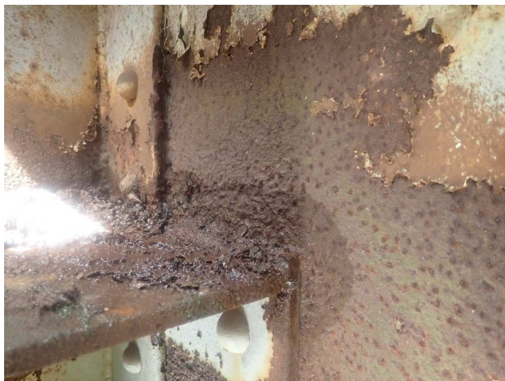
Foto č. 1 Konstrukce K 01 – stojina hlavního nosníku vpravo v napojení na 5. příčník – důlková koroze
