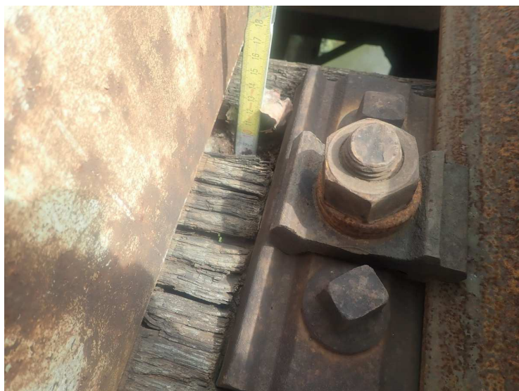
Foto č. 4 Železniční svršek – konstrukce K 01 – mostnice č. 31 vlevo – prohnílá
